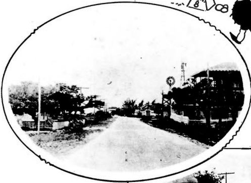
Un aspecto de la calle principal del Varadero, reparada y cubierta de tarvia.
