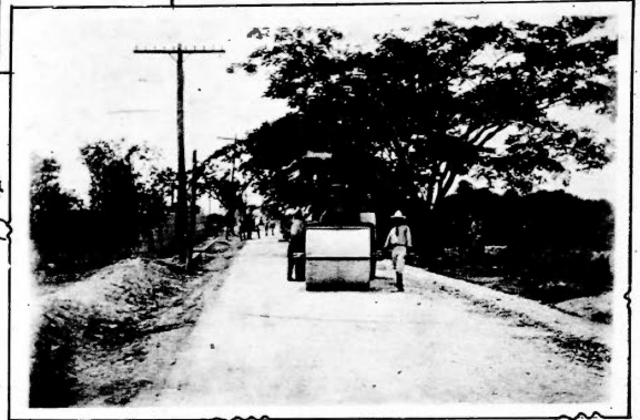
Estado de las reparaciones a la salida de Cárdenas, camino del Varadero.
