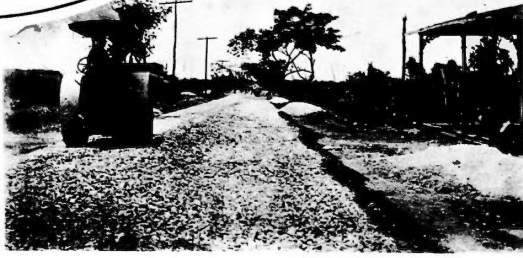
Un tramo de la carretera de Cárdenas al Varadero, en cuya reparación se trabaja activamente.
