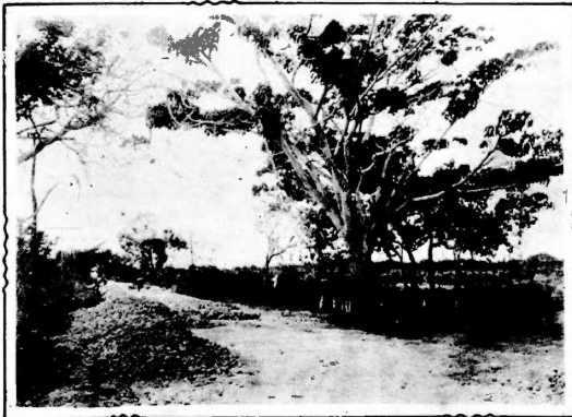
Carretera en construcción del Cementerio al Varadero.
